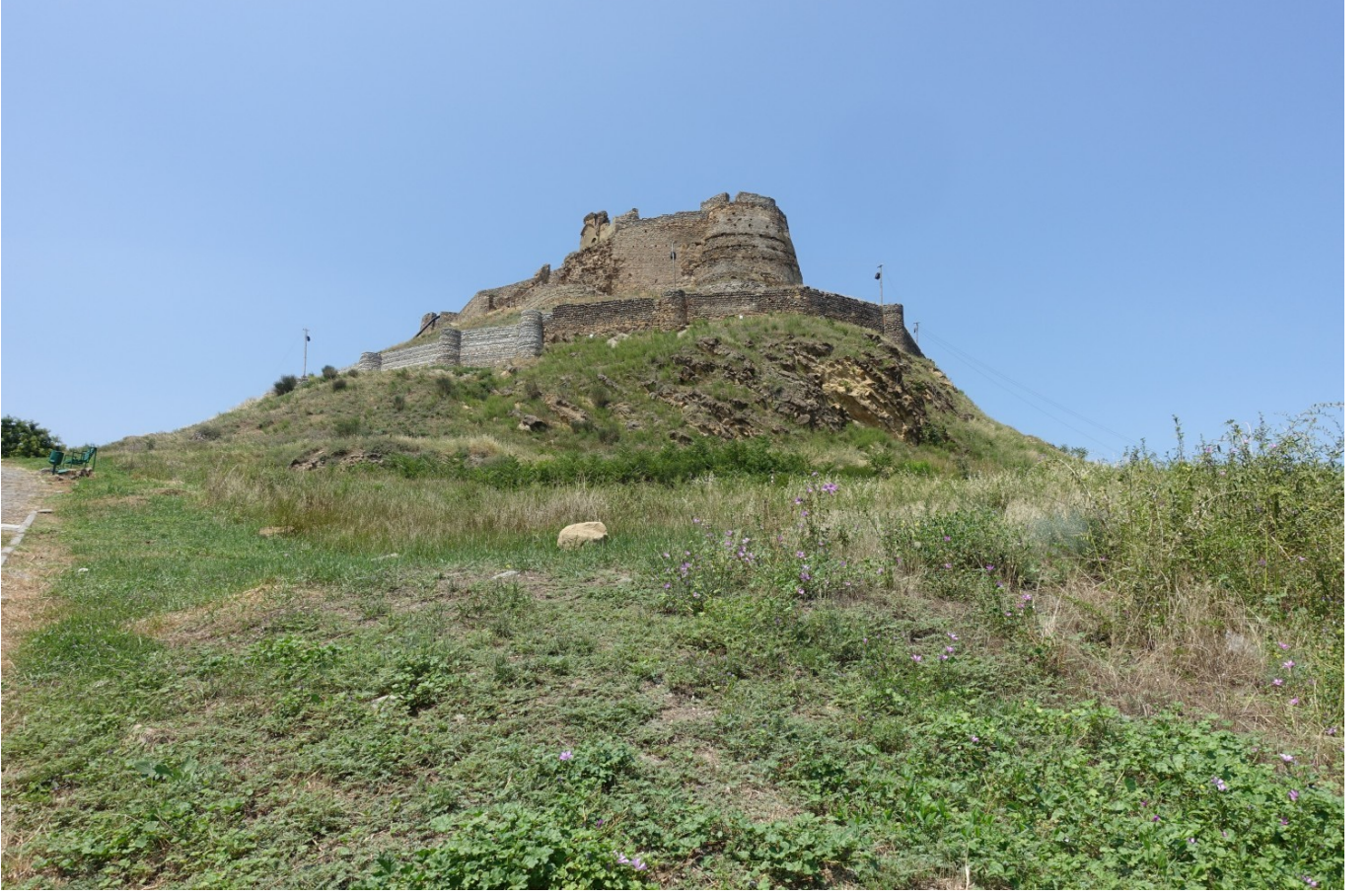
Gori kalesi, restorasyon 2020 de bitecekmiş. Şimdi hala çalışma var.
