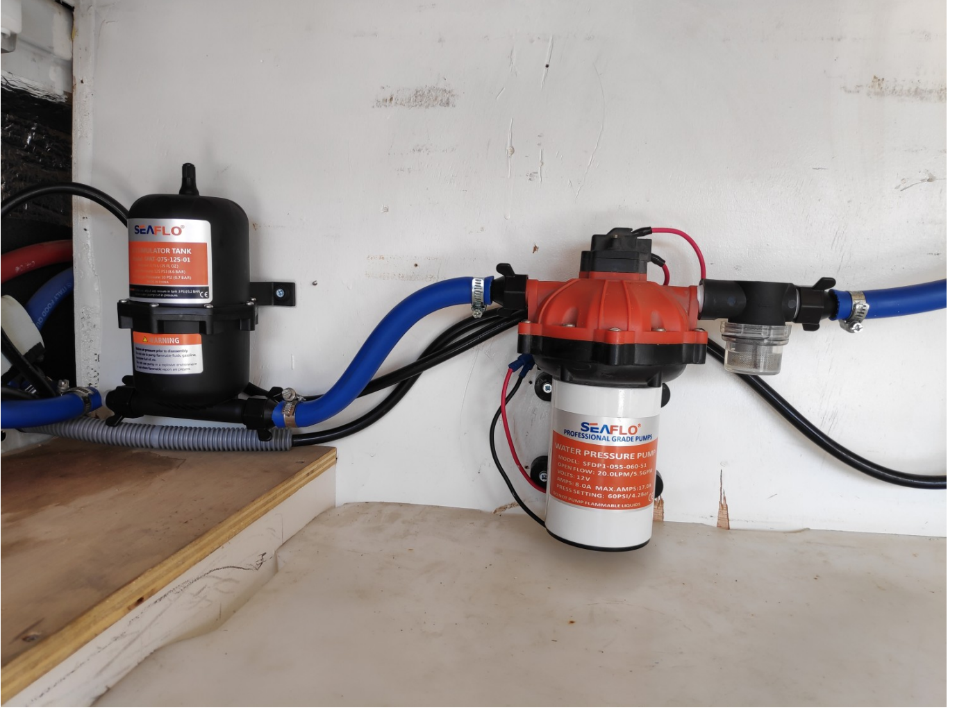
Sağda kullandığımız hidrofor, solda ise yeni taktığımız basınç dengeleme tankı.
